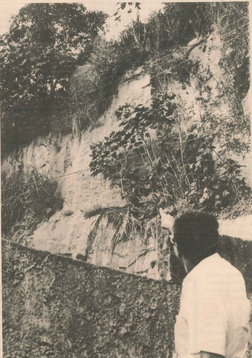
Técnicos mostraram aos moradores como evitar deslizamentos
