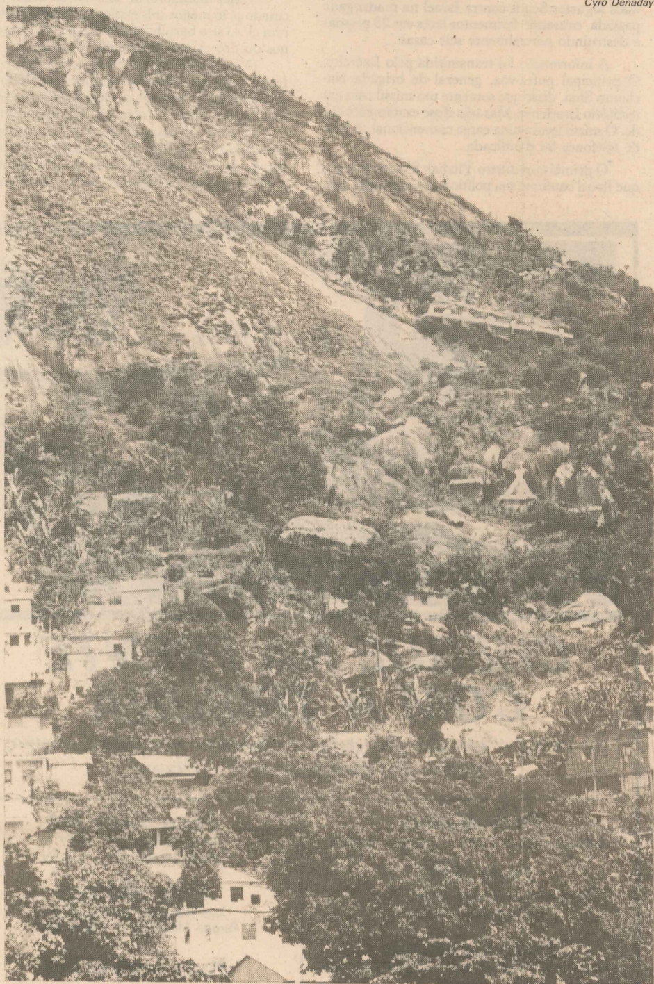
A erosão no Morro do Macaco pode provocar um novo deslizamento e causar mortes
