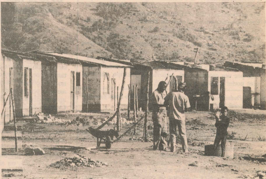
Mesmo incompletas algumas casas foram tomadas por invasores
