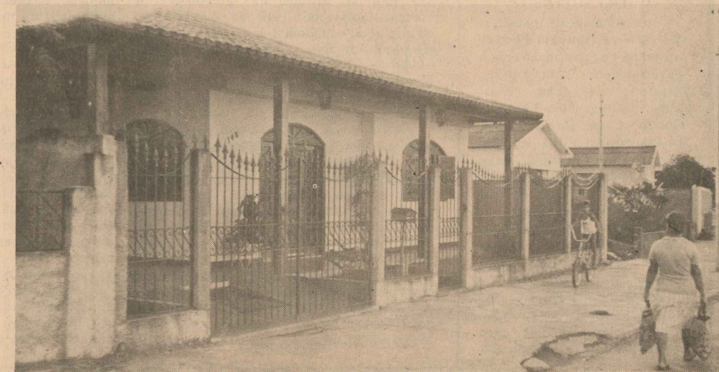
Muitos mutuários, buscando maior conforto, realizam reformas em suas casas.
