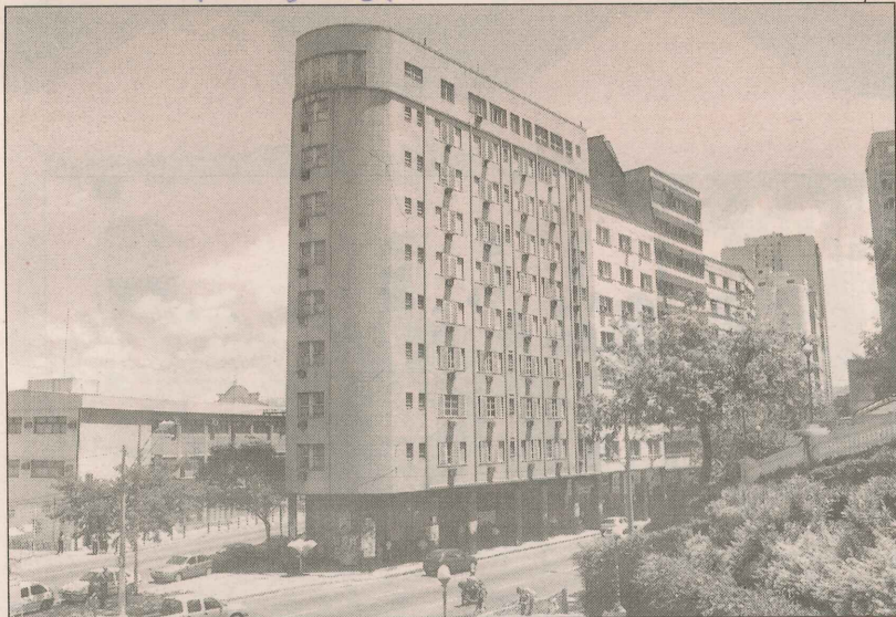
O antigo Hotel Estoril será transformado em unidade habitacional
