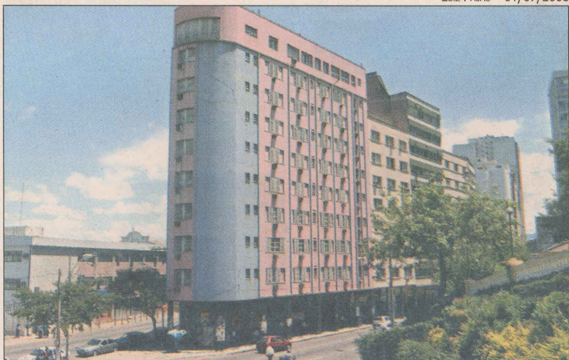
Edifício Estoril, que está sendo reformado para abrigar moradores
