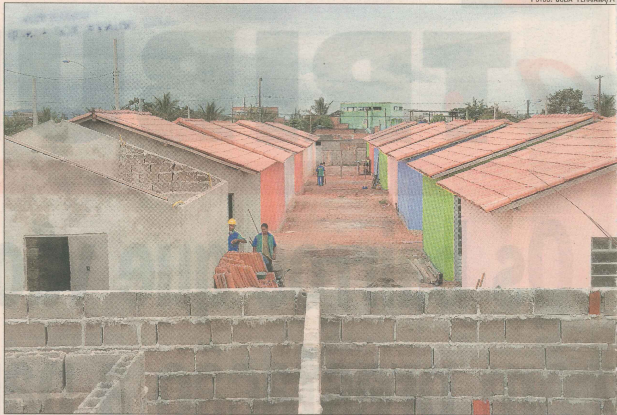
Construção de casas populares em Jabaeté, Vila Velha: município pode ser beneficiado
