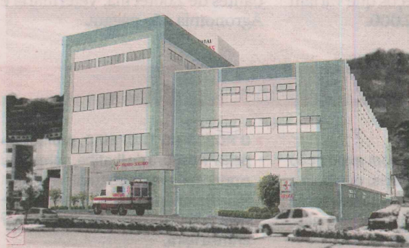
O NOVO HOSPITAL São Lucas está sendo finalizado em Vitória e deve ser entregue em 2013
