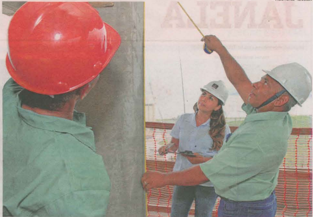
CANTEIRO DE OBRA: do projeto à execução, empreendimento demanda diferentes profissionais em cada fase
