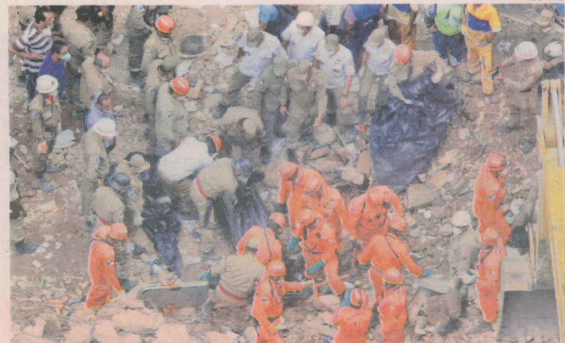
BOMBEIROS retiram corpos entre os destroços dos edifícios que caíram
