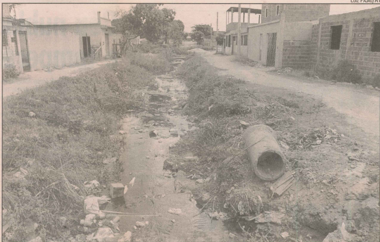
Em vez de rede de esgoto, valões com lixo acumulado em bairro de Cariacica
