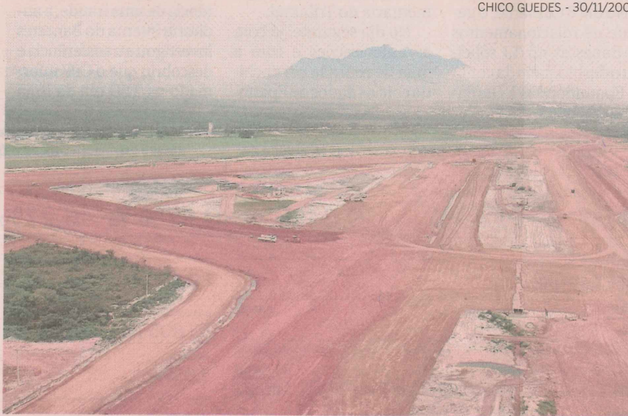
Obras paradas do Aeroporto de Vitória, alvo de suspeitas de sobrepreço
