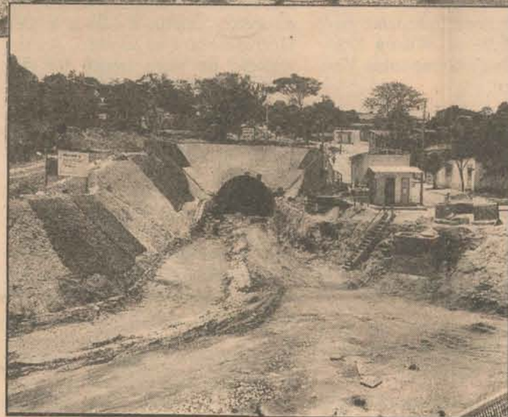
Emboque "B" (lado Dom Joaquim) do túnel de carga sob a Avenida José Cândido da Silveira, Belo Horizonte
