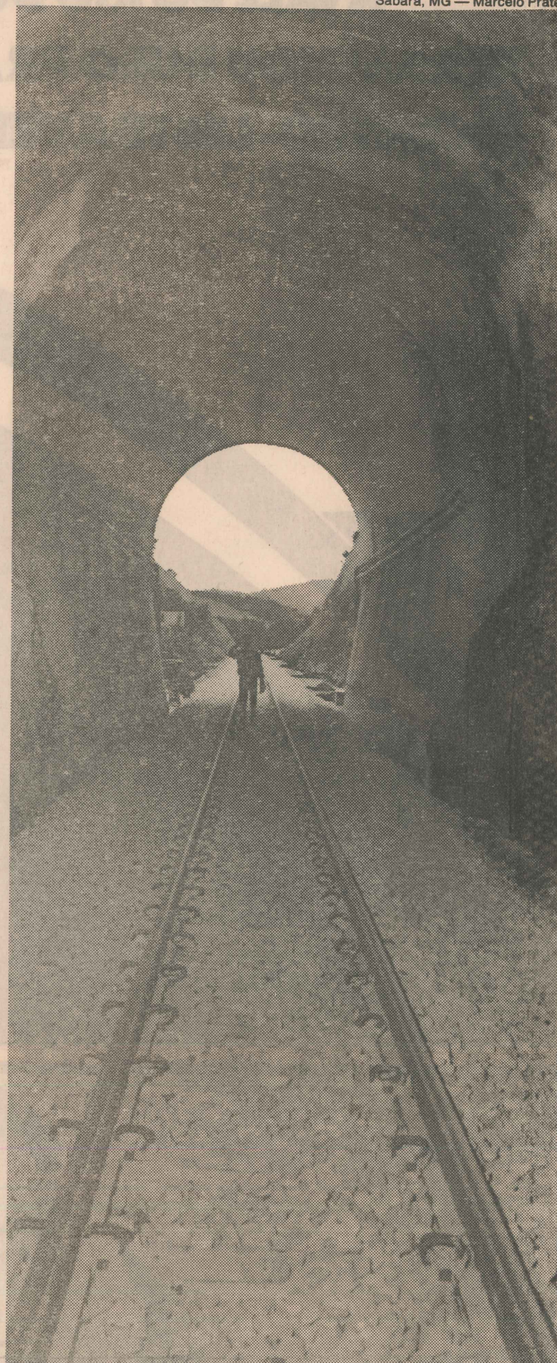
A conclusão do ramal exigiu a construção do túnel
