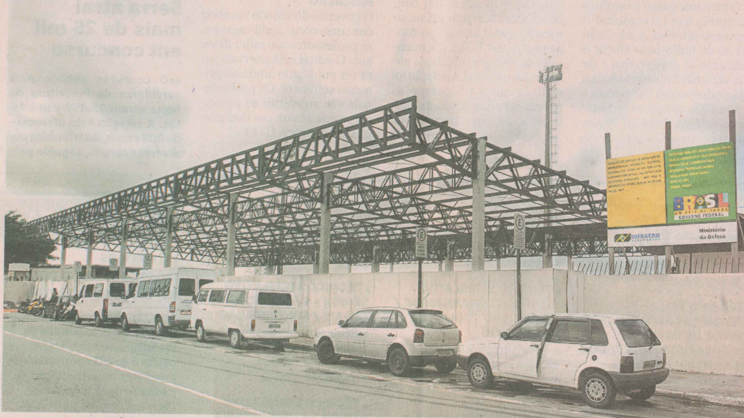
UM AEROPORTO PROVISÓRIO. Foi assinada ontem a ordem de serviço para o reinício das obras do Módulo Operacional
