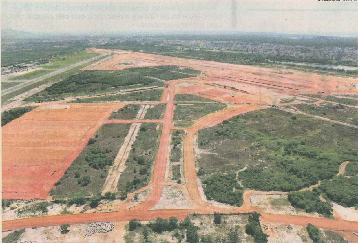
OBRAS DO AEROPORTO DE VITÓRIA: hoje, aviões de carga precisam dividir o mesmo pátio com os de passageiros
