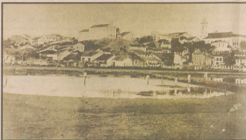
Arquivo da Biblioteca Central da Ufes
