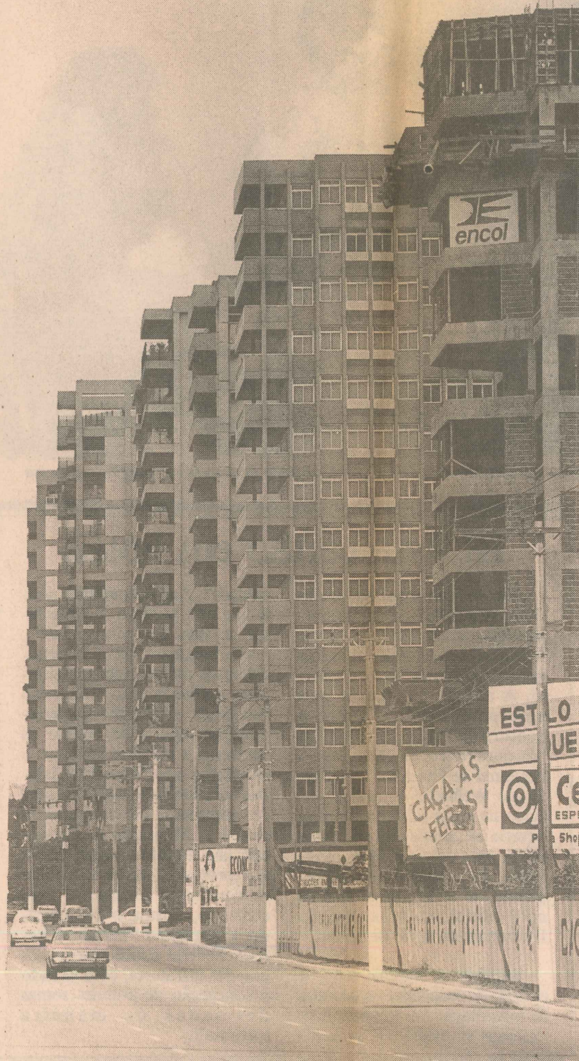
A mudança do gabarito dos prédios em áreas nobres divide as opiniões
