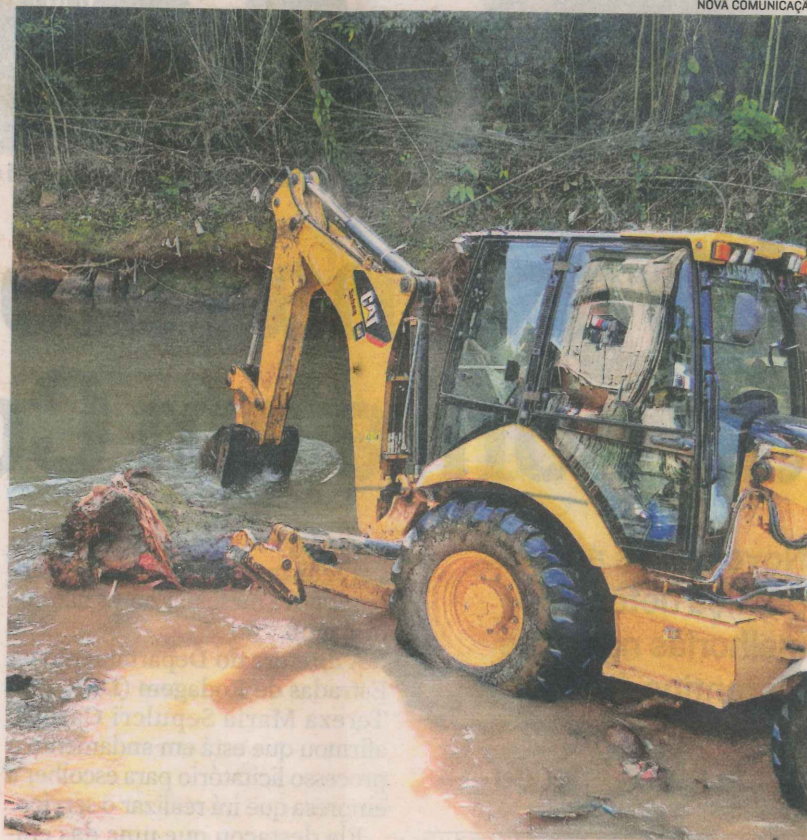
MÁQUINA trabalha no leito do manancial e faz a retirada de entulhos
