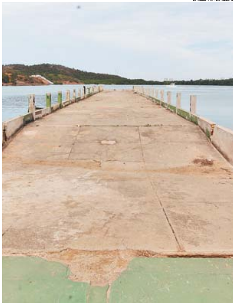
PÍER na avenida Beira-Mar, em Vitória, onde funcionou terminal aquaviário
