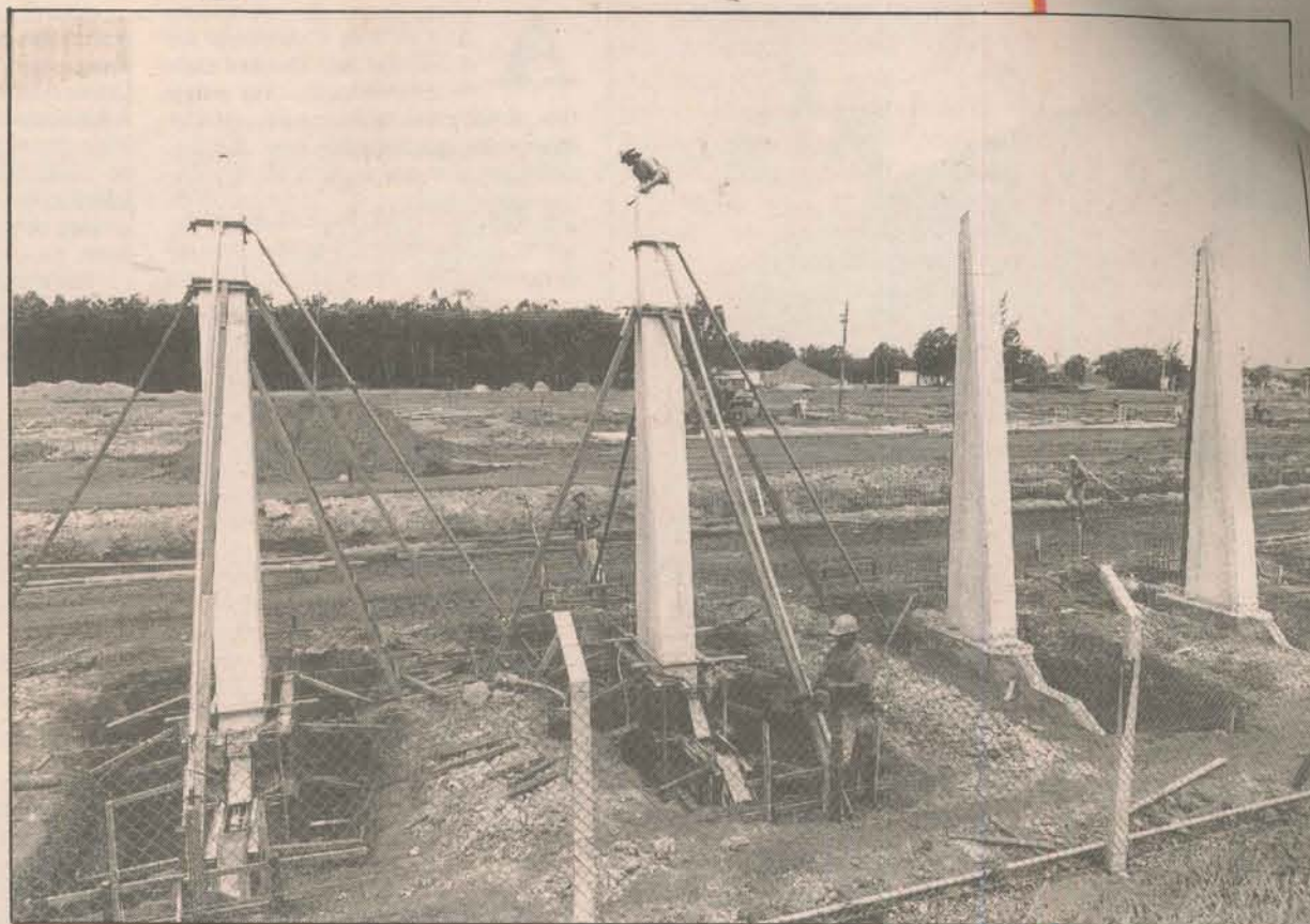
A estrutura dos novos silos está sendo montada. Com inauguração para abril
