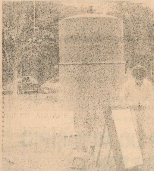
Instalações do Projeto Aguapé, com o reservatório de metano.
