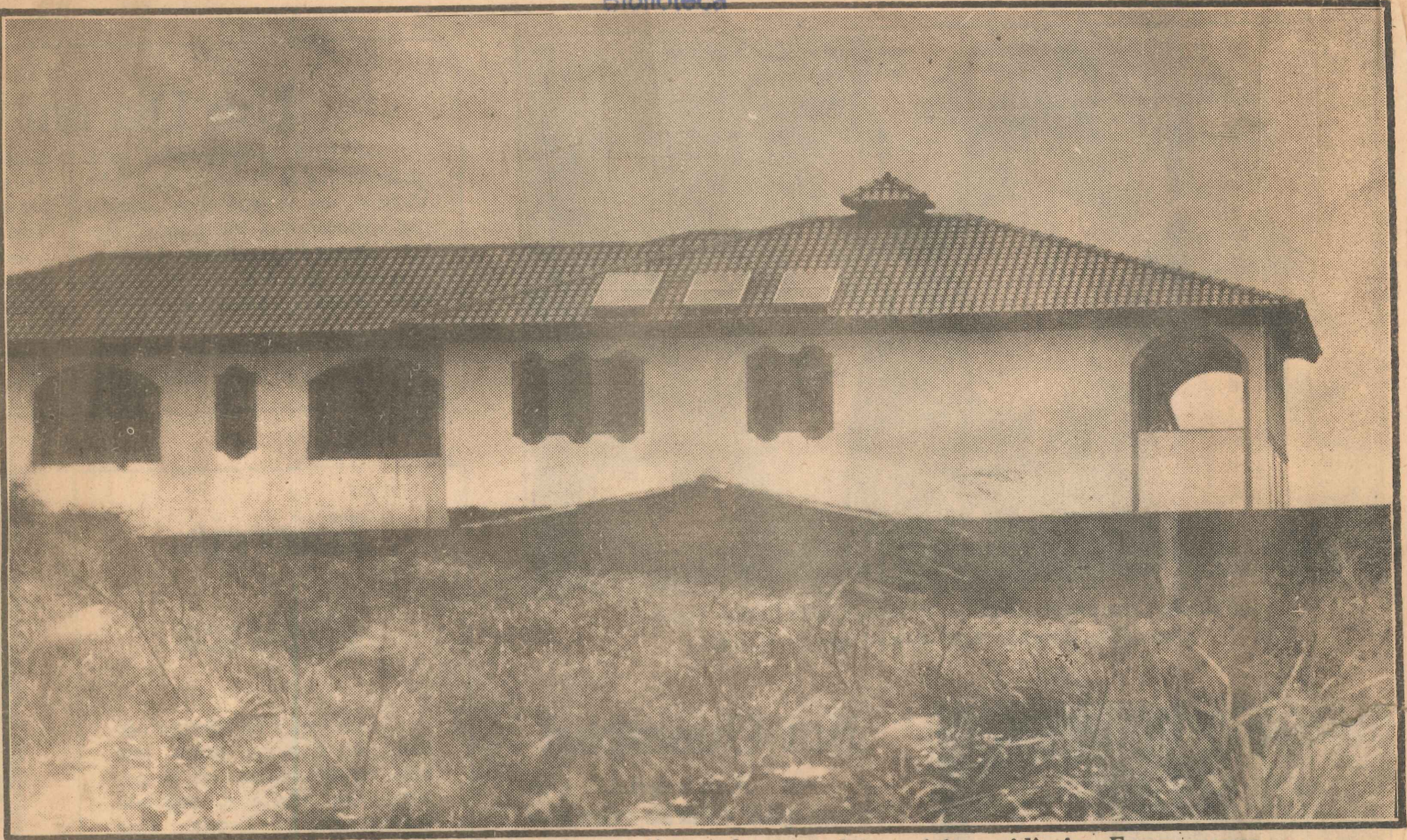
Na Ilha do Boi, o sistema de aquecimento já está funcionando em várias residências. E com sucesso.
