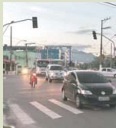
VIADUTO na Fernando Ferrari
