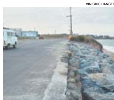
TRECHO em obra na Rodovia do Sol
