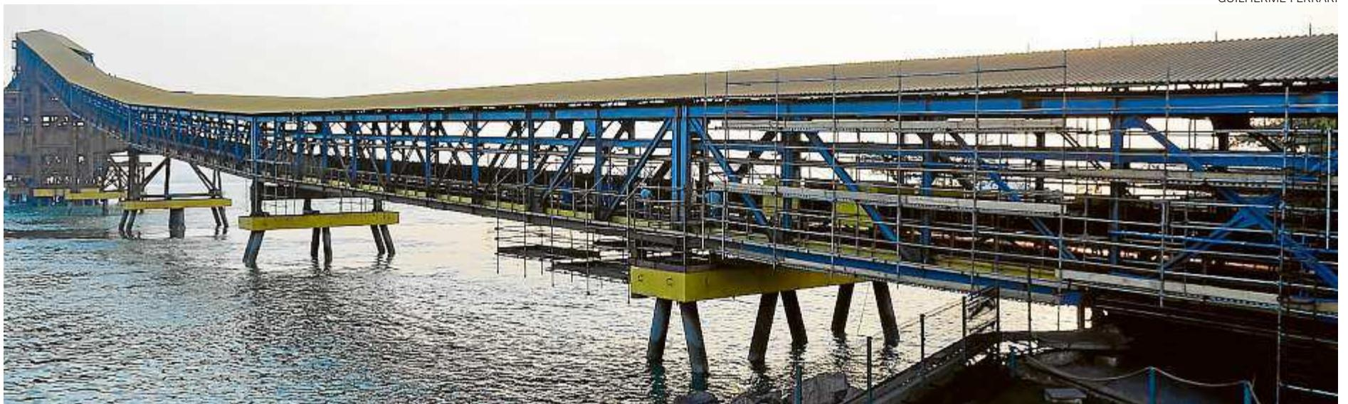
A correia transportadora que alimenta o Píer II será fechada com quatro mil metros quadrados de telhas de alumínio intercaladas com telhas translúcidas
