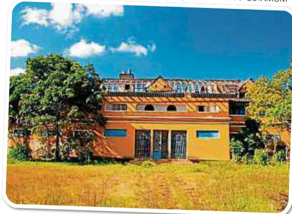
O imóvel, antes do desabamento recente
