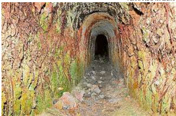
Saída do túnel subterrâneo na Lagoa de Carapebus
