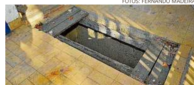
Fundo falso nas entradas da casa dava em túneis
