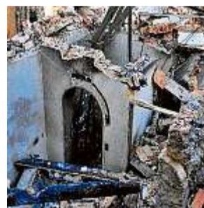
Fosso do elevador
