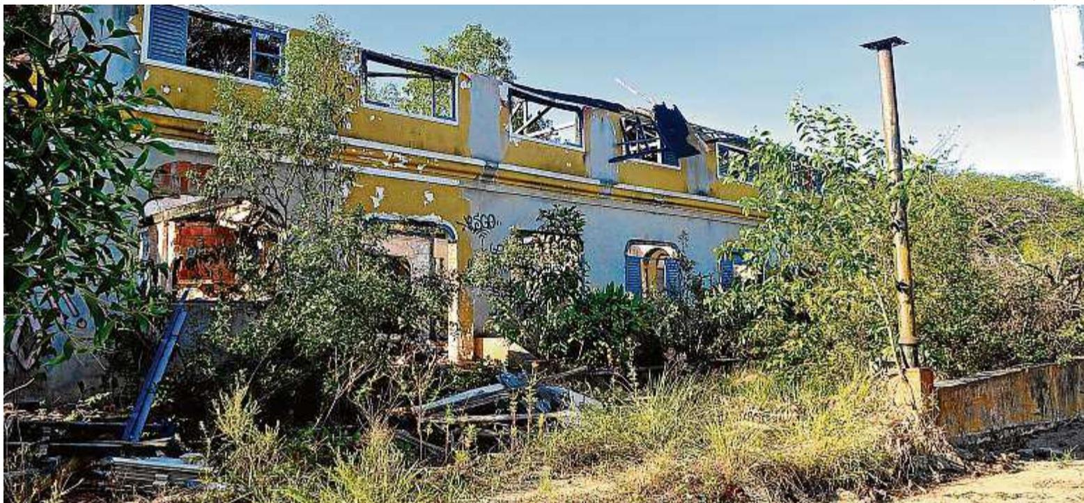
O casarão em Carapebus sofre com a ação do tempo. A estrutura de alvenaria reforçada com madeira sofreu muitos danos após dois incêndios
