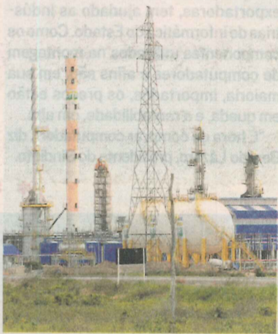
UTG CACIMBAS: novo gasoduto
