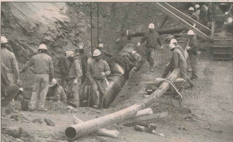
Operários da Petrobras trabalham em construção de gasoduto
