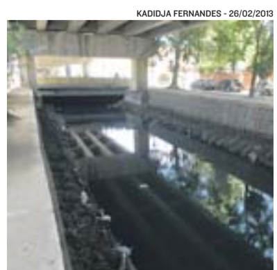
CANAL da Costa: retirada de pedras
