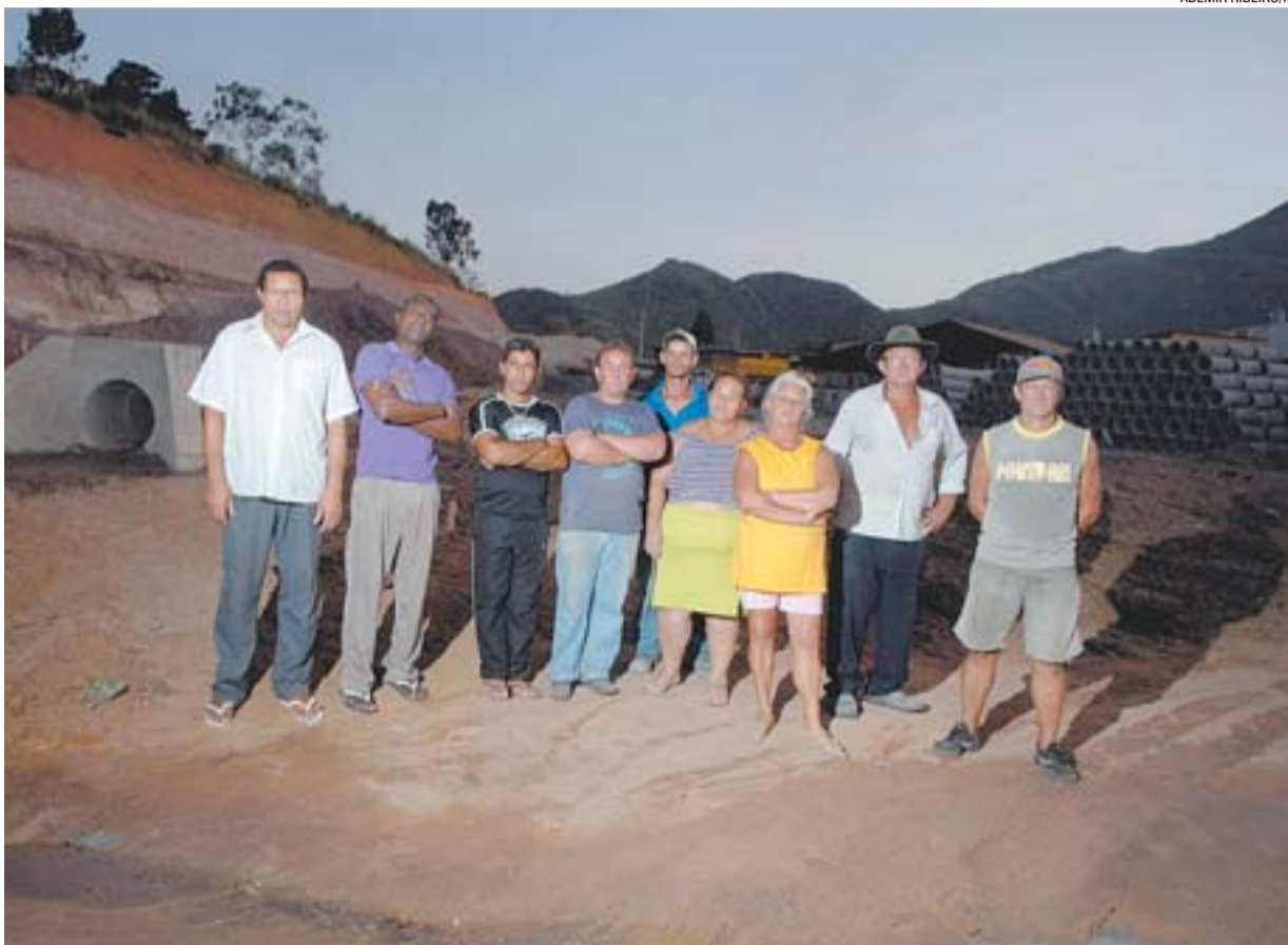
MORADORES vão ter de deixar suas casas para término da obra. Eles dizem que ainda não receberam indenização
