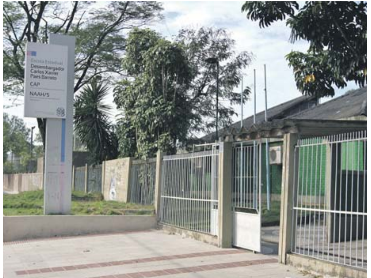
ESCOLA ESTADUAL Desembargador Carlos Xavier Paes Barreto será demolida e reconstruída na mesma região
