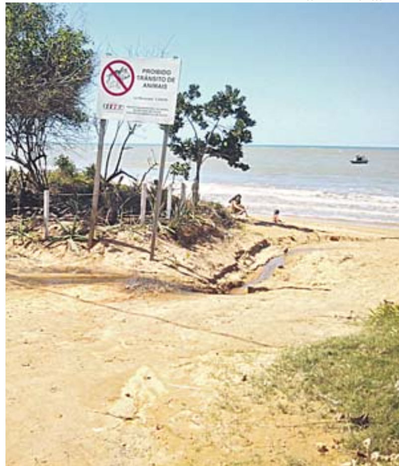
ESGOTO corre a céu aberto na Praia da Ponta dos Fachos, em Manguinhos
