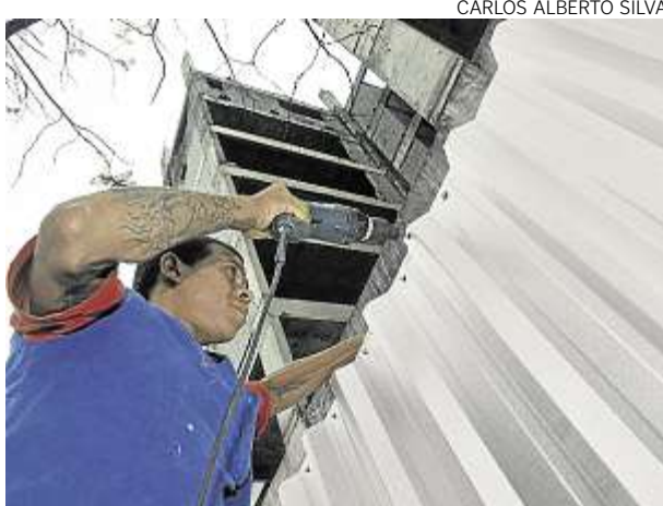
Tapumes foram colocados em volta da estrutura
