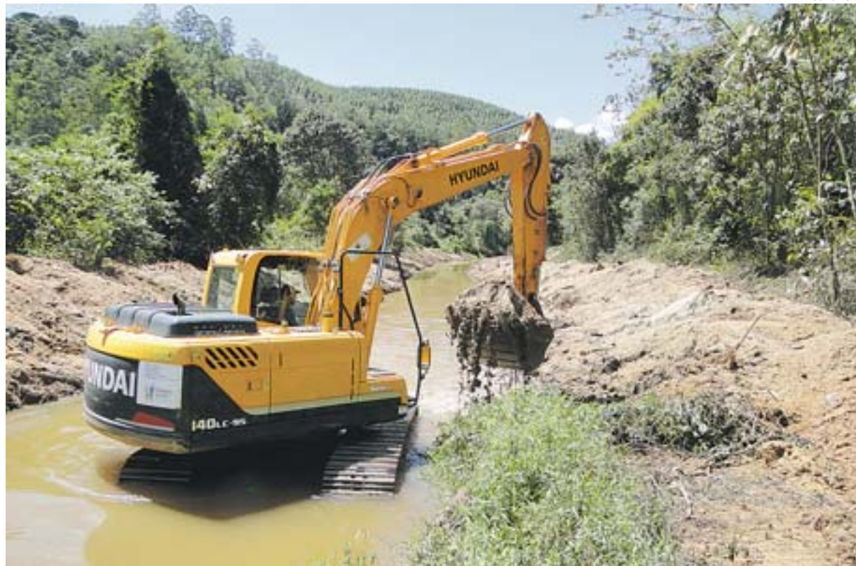
MÁQUINA realiza a limpeza do rio Fundo, em Marechal Floriano, na região serrana do Estado, para evitar enchentes
