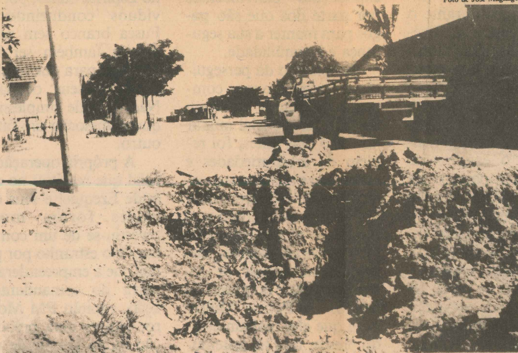
As ruas do Bairro das Flores estão esburacadas e a iluminação é deficiente
