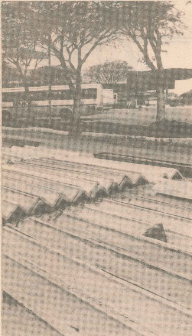
A construção do muro amplia as condições de segurança
