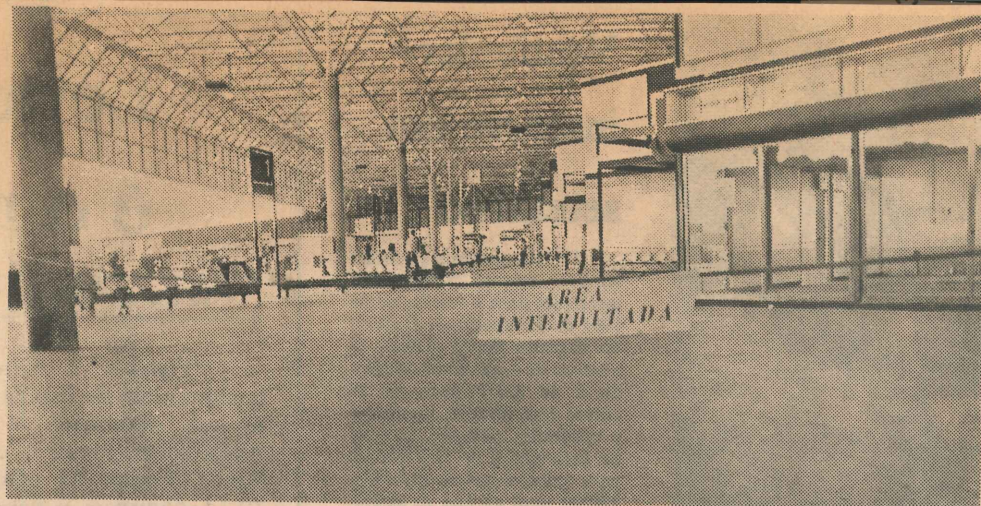
A área da Rodoviária que apresentava rachaduras continua interdita.
