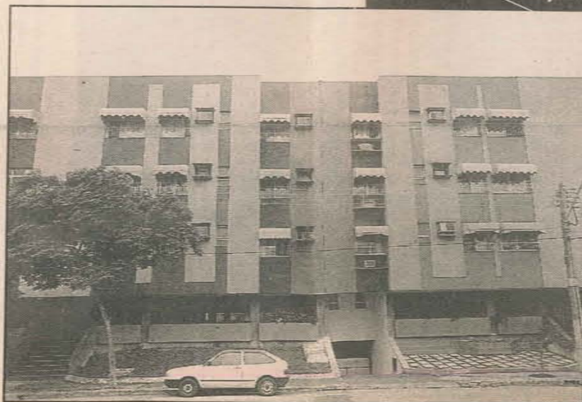
Edifícios Michel, Michele e Flávia, em J. Camburi exemplo de prédios 'colados'
