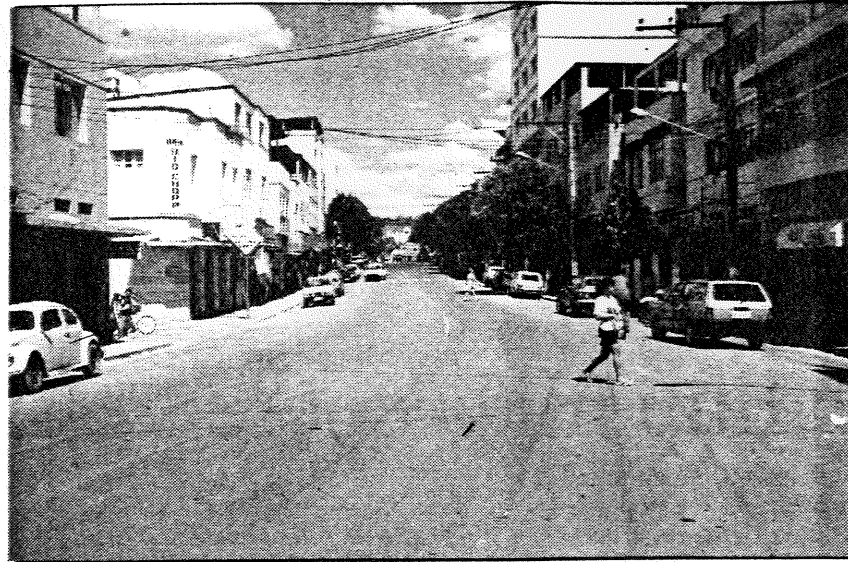
Asfaltamento do centro de São Gabriel
