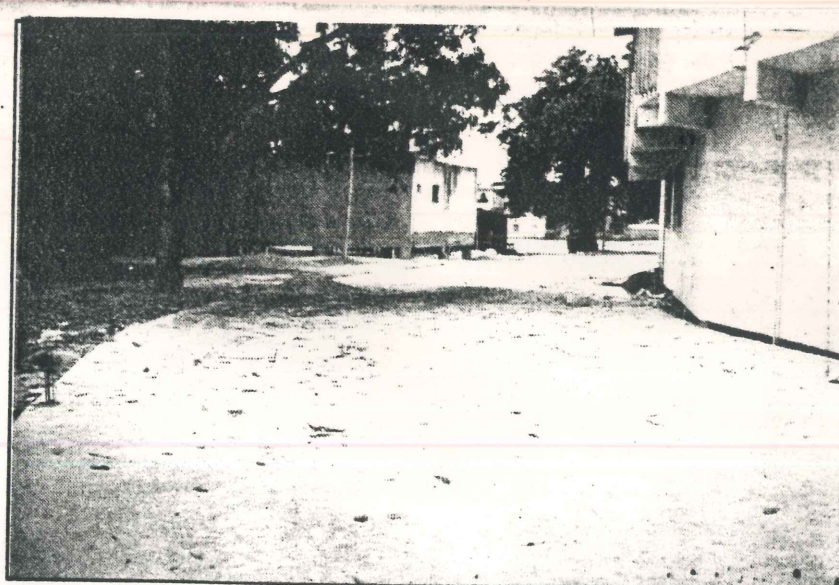
Primeira etapa da galeria pronta: um desafio vencido pela Administração Municipal
