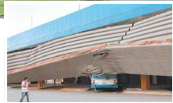
**TERMINAL** de Itaparica reformado (acima). Ao lado, quando parte do telhado caiu por causa do vendaval
