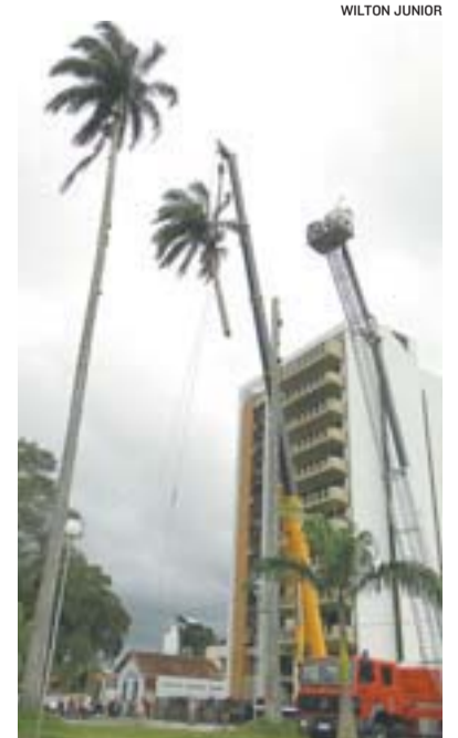
GUINDASTE para retirar a árvore
