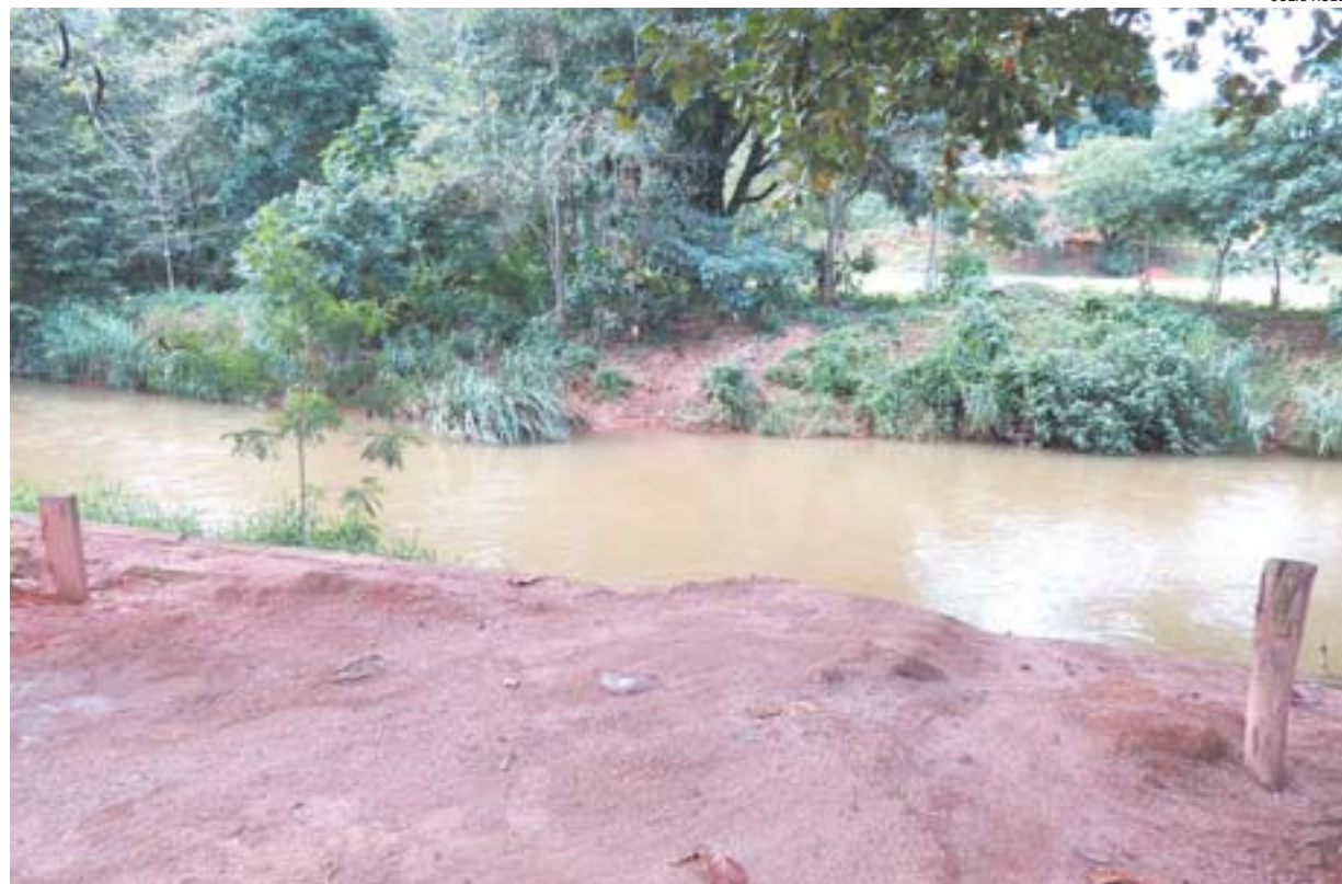
LOCAL onde será reconstruída a passarela que dá acesso ao Parque de Exposições em Alfredo Chaves
