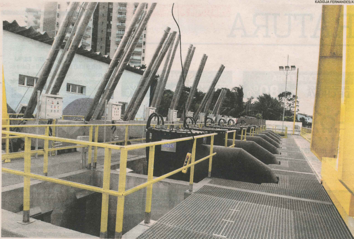
ESTAÇÃO DE BOMBEAMENTO será inaugurada hoje em Santa Luíza. Galerias já existentes também serão ampliadas
