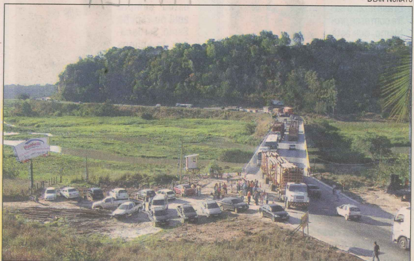
Abertura total da ponte sobre o rio Itaúnas, em Pedro Canário
