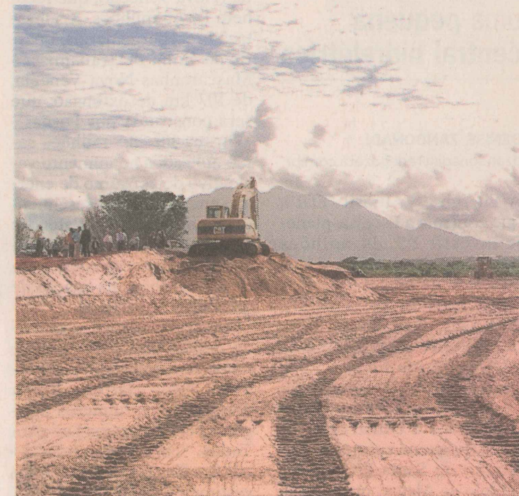
ATRASO. Até março já terá encerrado o prazo de dois anos que o presidente Lula deu para a conclusão das obras. FOTO: GILDO LOYOLA
