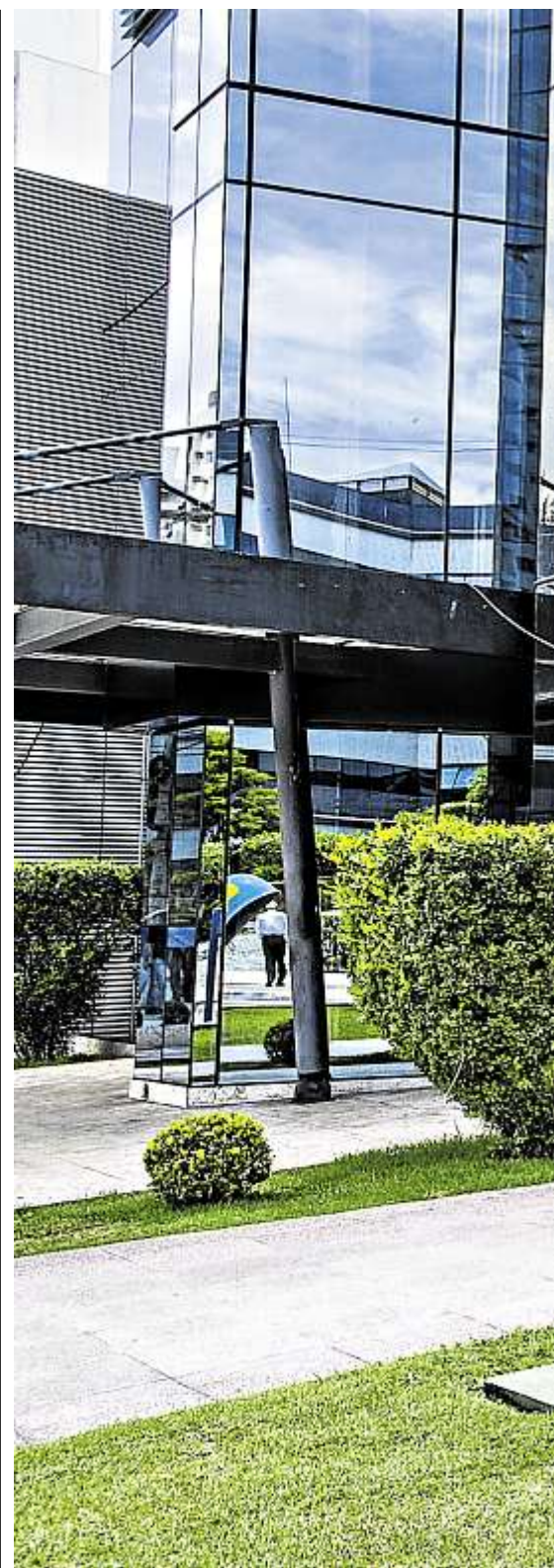
Uma das obras de Vilar na Enseada do Suá, em Vitória.
