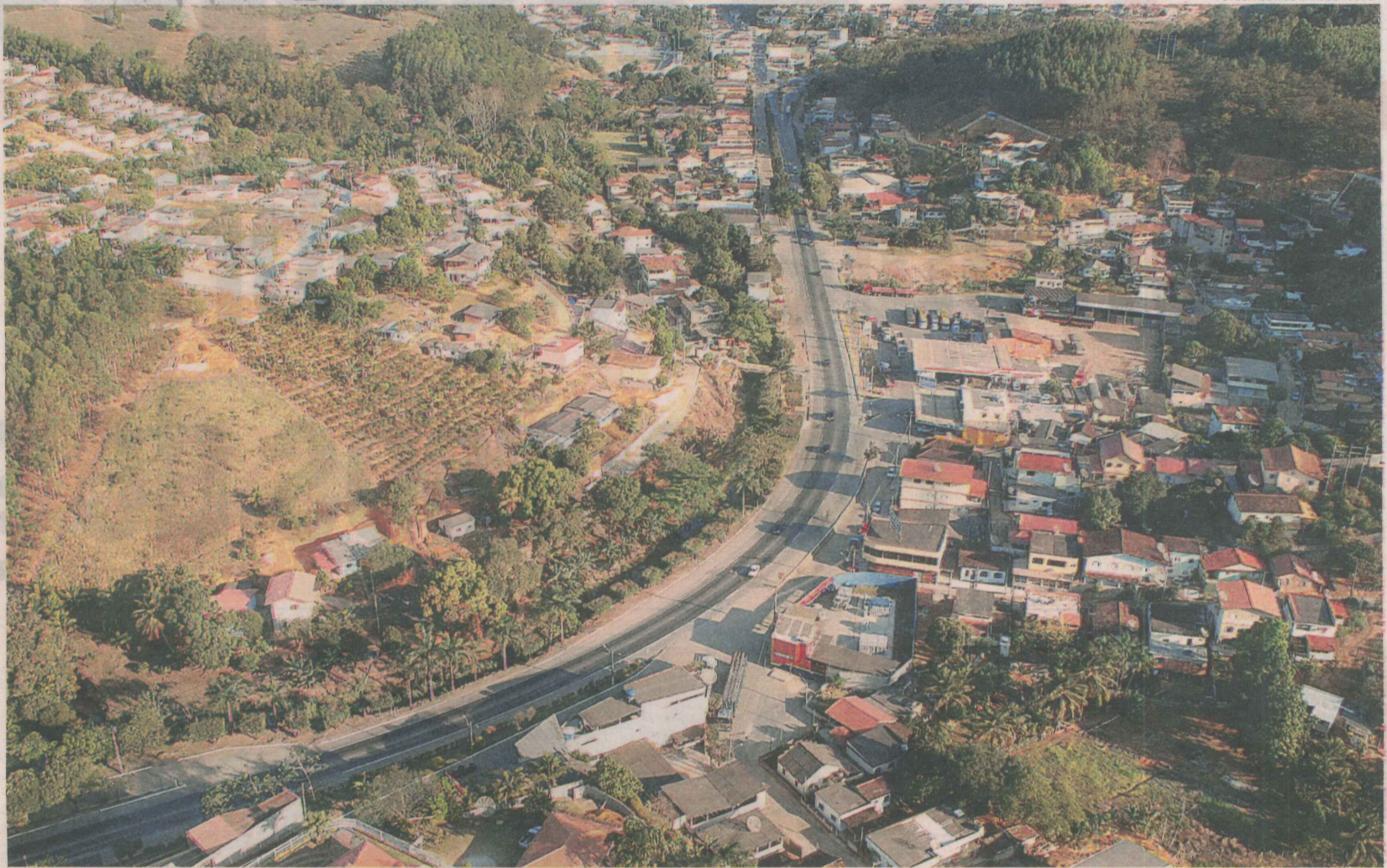
BAIRRO EM IBIRAÇU cortado pela BR-101: obras de melhoria para redução de acidentes na primeira fase do projeto de concessão da rodovia
