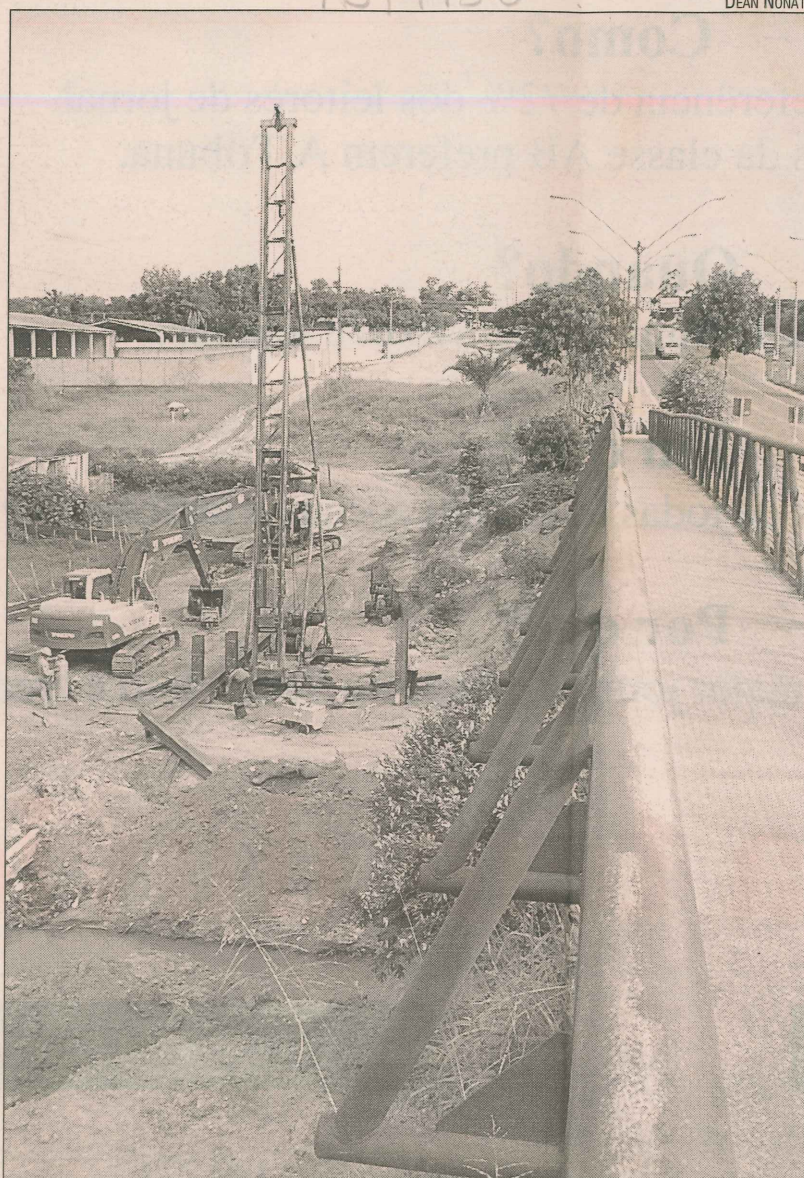
As obras da BR-101 Norte devem terminar em novembro
